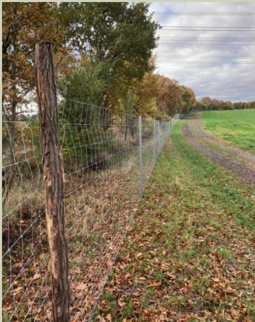
Abbildung 24: Wildzaun mit Z-Profilen, Robinienstangen und Knotengeflecht. (Abb.: C. Weinhold 2024)
